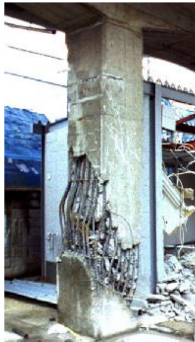
Slika 1.4.a - Ilustracija loma stuba usled zemljotresa
