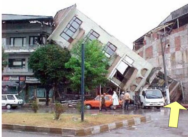
Slika 1.24 - Preturanje objekta usled popuštanja temelja
