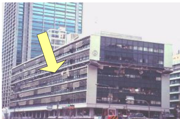
Slika 1.21-Kolaps četvrtog sprata usled efekta fleksibilnog sprata (Japan 1995)
