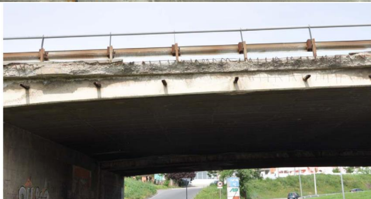
Оштећење венца пешачке стазе услед сливања воде са конструкције
