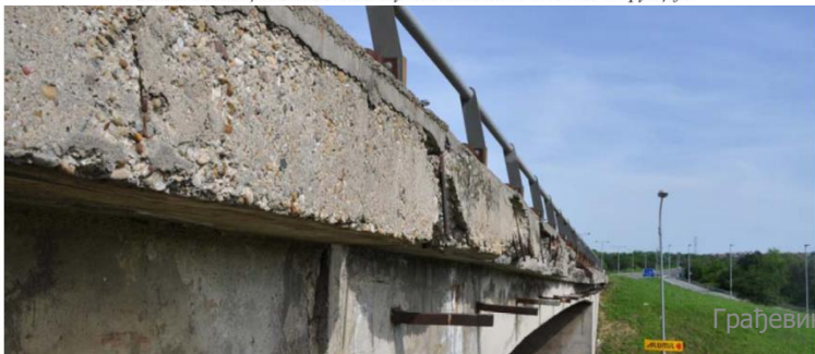
Оштећење венца пешачке стазе услед сливања воде са конструкције
