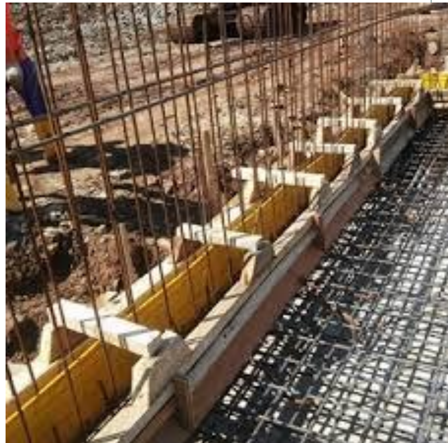
Pre betoniranja prve faze (temeljne ploče) Postavljanje gumene waterstop traka na spoju temeljne ploče i zida
