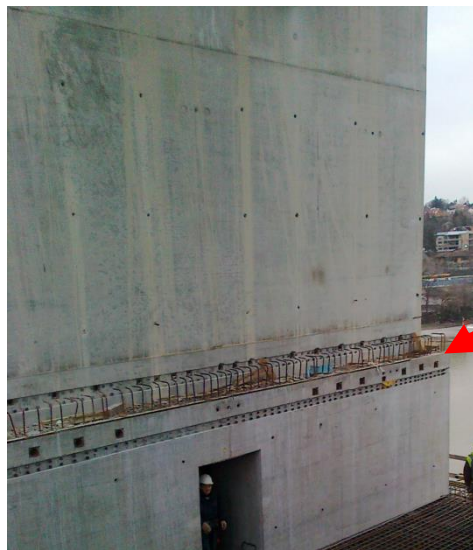
Veza pomoću kaplera sa pločom grede mosta
