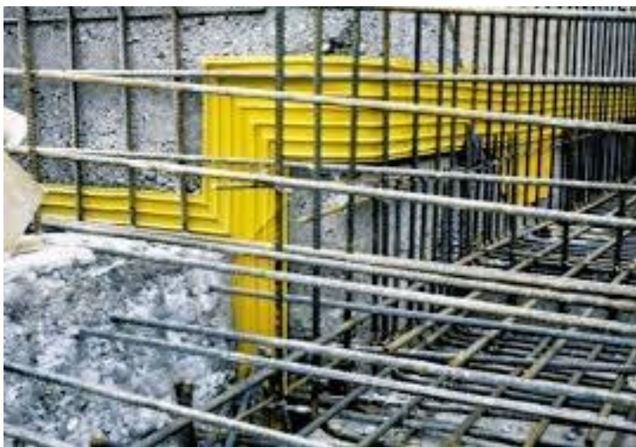
Posle betoniranja prve faze (temeljne ploče)
