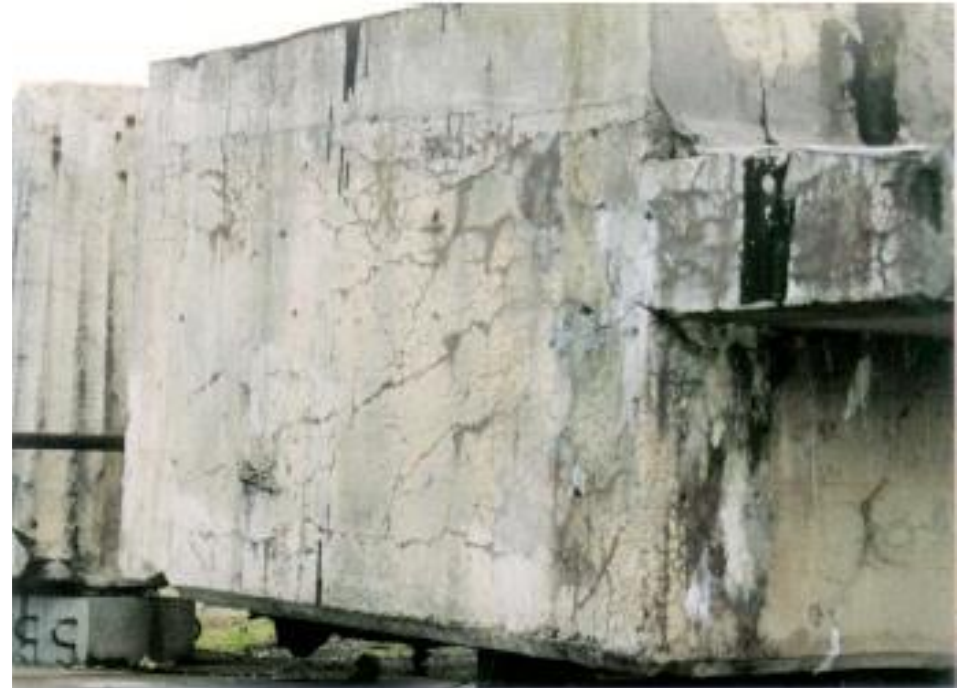
Oštećenja usled alkalno-agregatne reakcije
