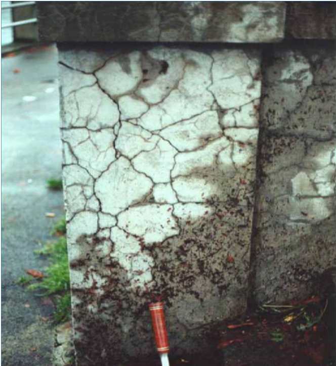
Oštećenja usled alkalno-agregatne reakcije
