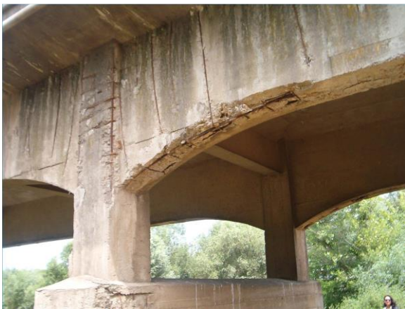
Korozija armature i otpadanje zaštitnog sloja betona (karbonatizacija, hloridi)
