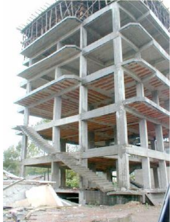
Slika 2.23 - Praktično neoštećena ramovska konstrukcija u izgradnji (Turska 1999.)
