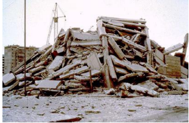
Slika 2.21 - Kolaps montažne ramovske konstrukcije (Spitak-Jermenija 1988.)
