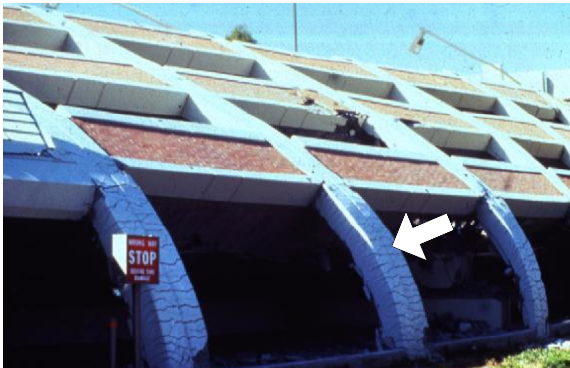
Slika 4.42 - Detalj povijenog fasadnog okvira nakon pada tavanica (SAD 1994.)
