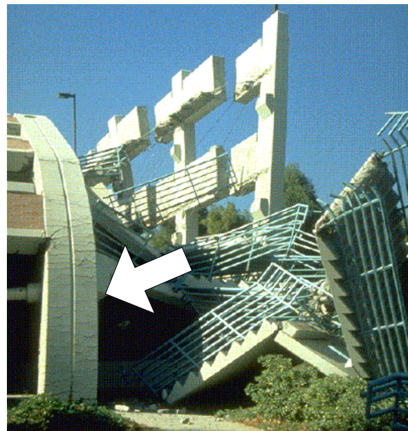
Slika 4.41 - Pad horizontalnih konstrukcija zbog kidanja veza sa okvirima (SAD 1994.)
