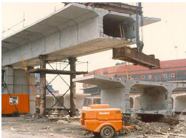
Slika 1.32 Segmentno gradjenje mosta
