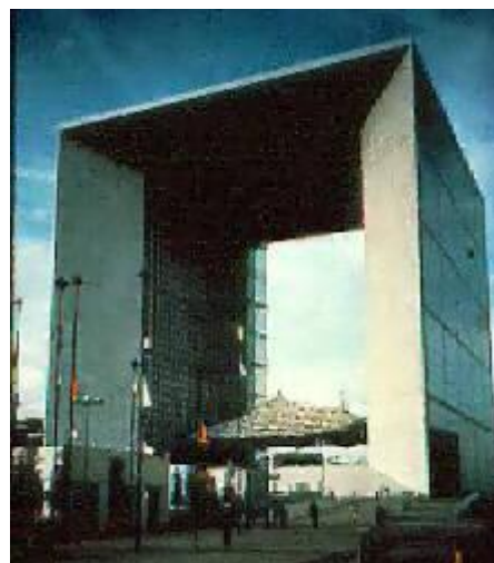
Slika 1.29 Prethodno napregnuta konstrukcija 'mostovskih' etaža
