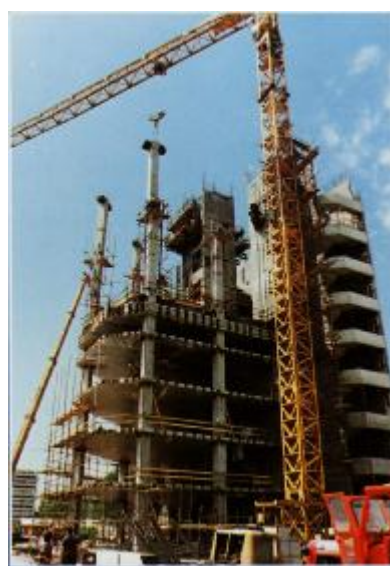
Slika 1.40 Prethodno napregnute liftovane tavanice, sistem Trudbenik
