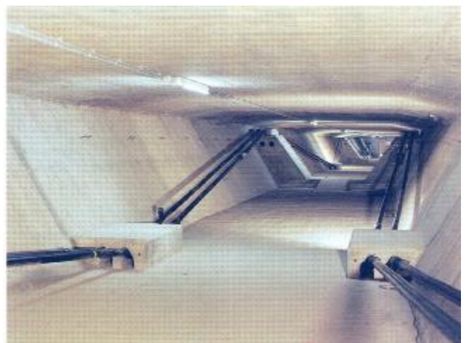
Slika 1.33 Spoljašnje prethodno naprezanje mosta
