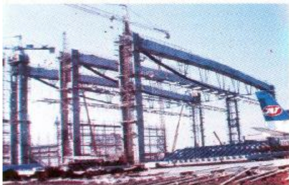
Slika 1.43 Glavni nosači hangara JAT-a u Surčinu u fazi gradjenja
