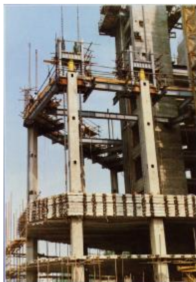
Slika 1.40 Prethodno napregnute liftovane tavanice, sistem Trudbenik
