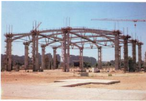
Slika 1.45 Spoljašnje prethodno napregnuta konstrukcija krova 'Beogradske Arene'
