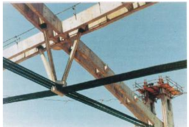
Slika 1.46 Detalj gornjeg pojasa, kablova, stolica i devijatora 'Beogradske Arene'
