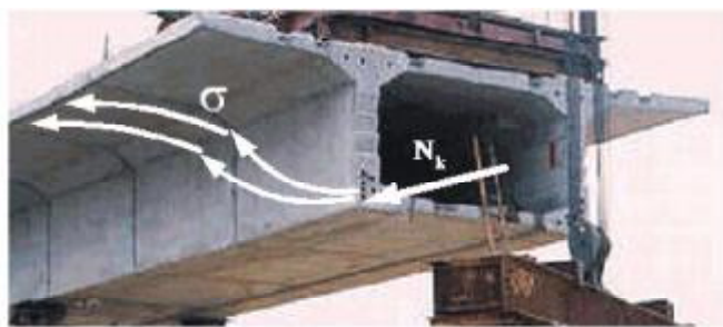
Slika 2.19 Rasprostiranje napona usled prethodnog naprezanja
