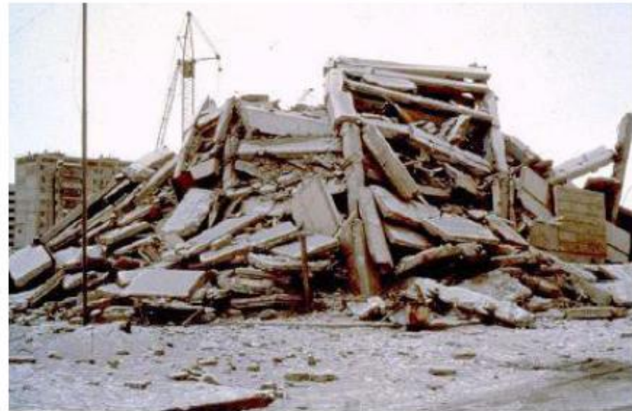
Slika 2.21 - Kolaps montažne ramovske konstrukcije (Spitak-Jermenija 1988.)
