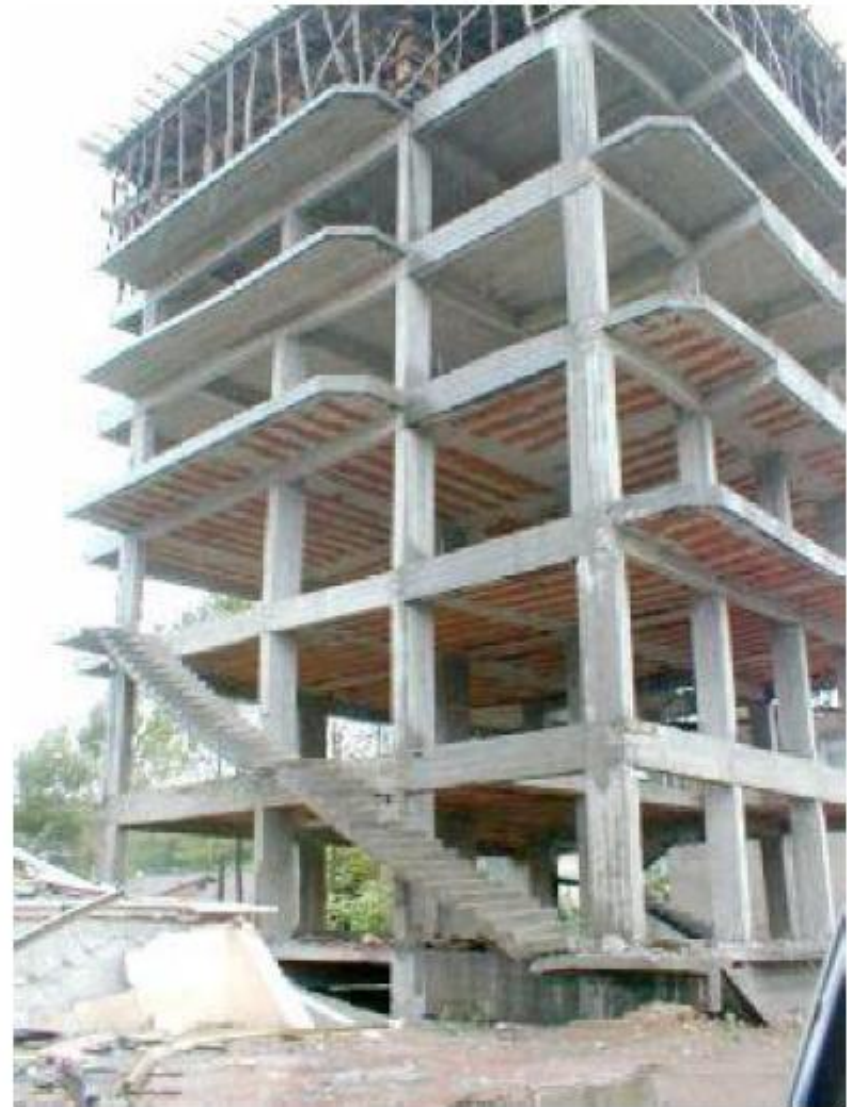
Slika 2.23 - Praktično neoštećena ramovska konstrukcija u izgradnji (Turska 1999.)
