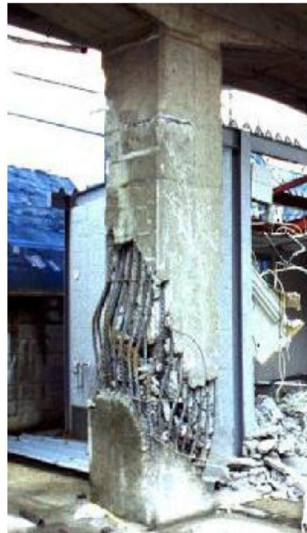
Slika 1.4.a - Ilustracija loma stuba usled zemljotresa
